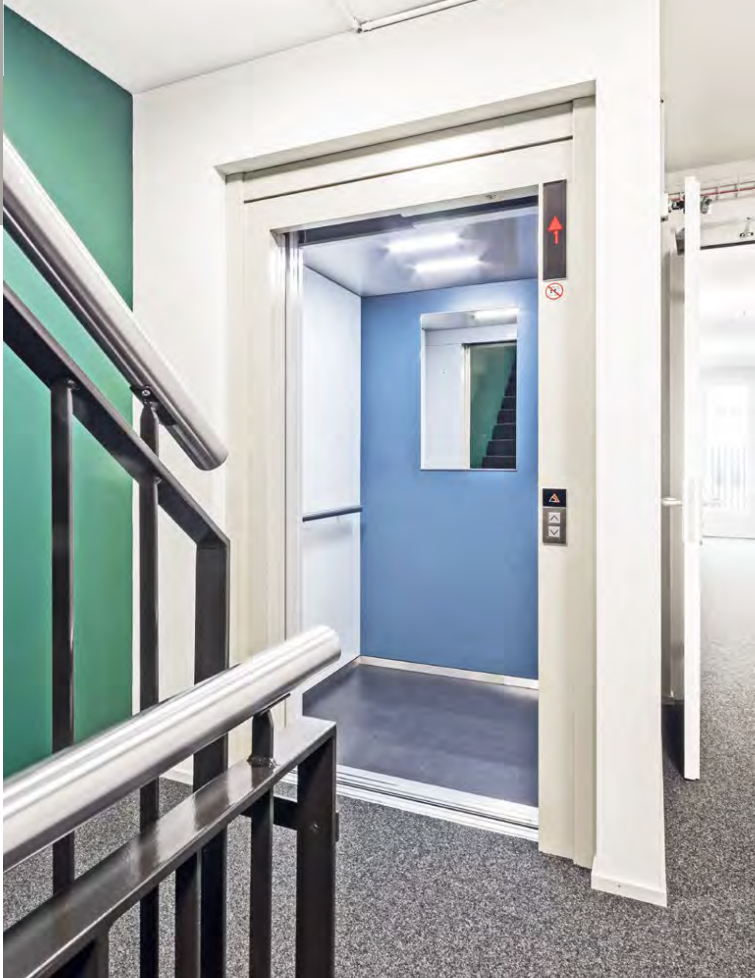
Bild linke Seite Mit dem Gebäude wird dereinst auch der AS-Lift mitgezogen. Dabei wird es die grosse Erfahrung der Liftmonteure brauchen.
